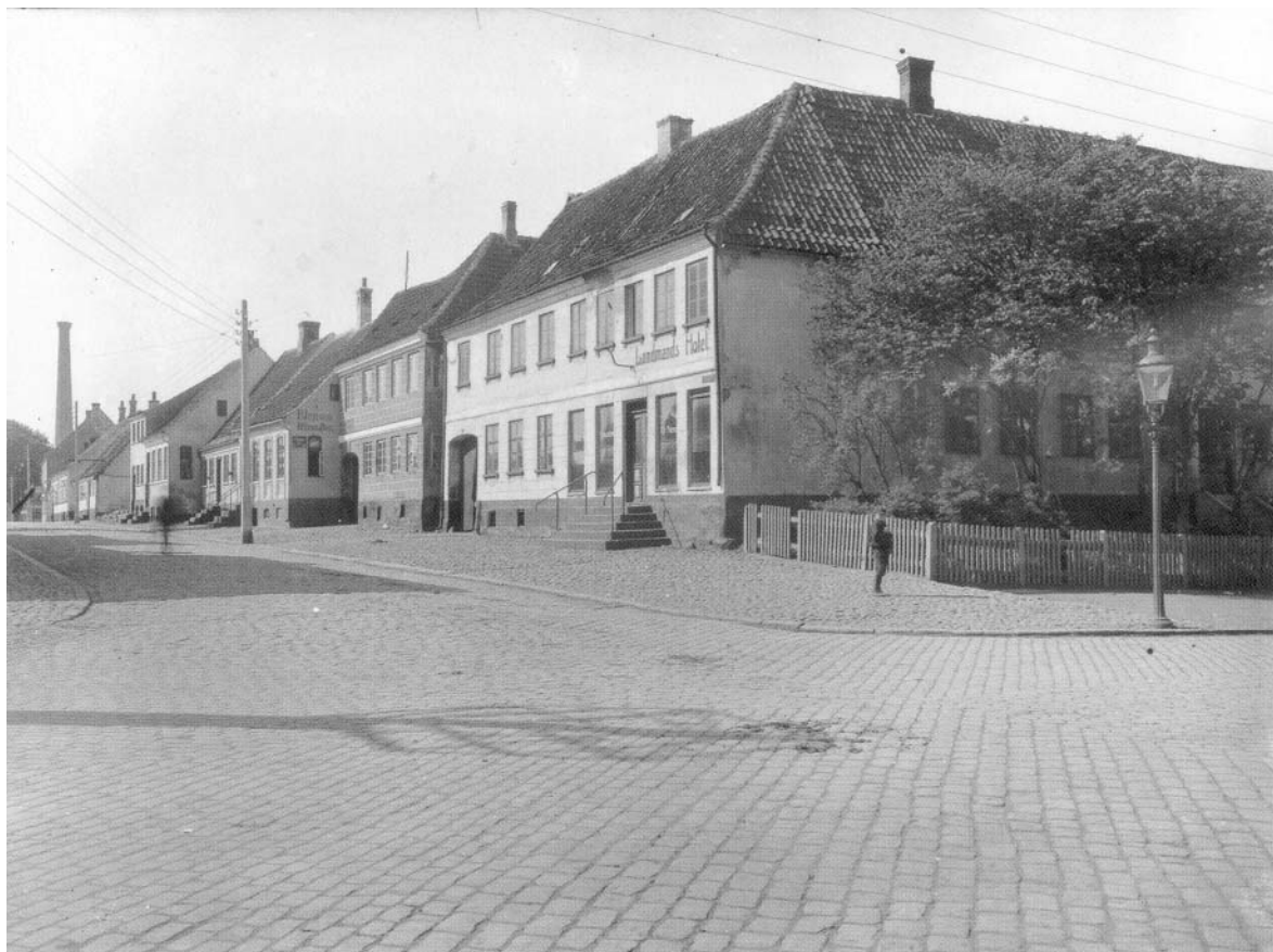
Her ses vestsiden af Damgade med en række af de lige husnumre. På hjørnet ligger Landmandshotellet i nr 12 (dobbelthus). Derefter følger nr. 14, som tilhørte familien Østerbye i en årrække. Huset var oprindeligt et gavlhuis med en port ind til ejendommens bagbygninger.
